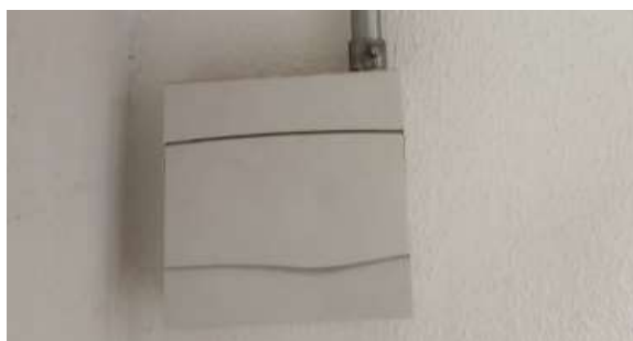
Figura 5: Quadro de distribuição presente no interior do box.
